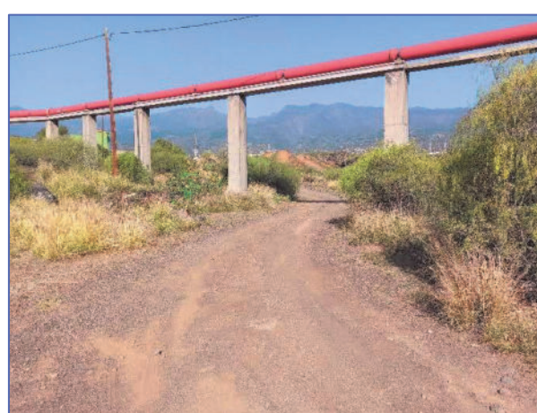
Fotografía 19: Aspecto de parte del trazado de la línea de evacuación.
