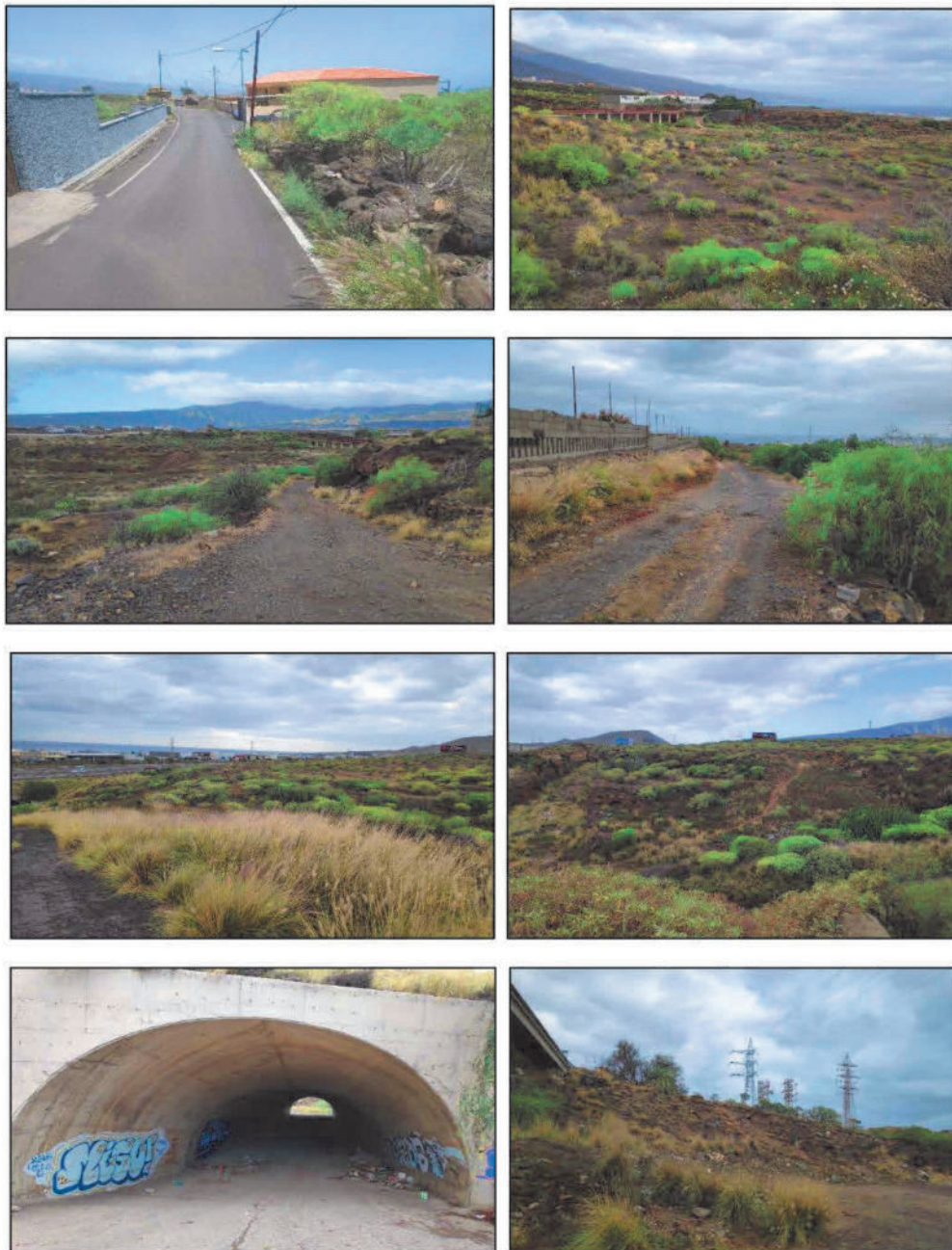
Fotos 9-18 Trazado para la instalación de la Línea de Evacuación hasta la Subestación Polígono de Güímar.
