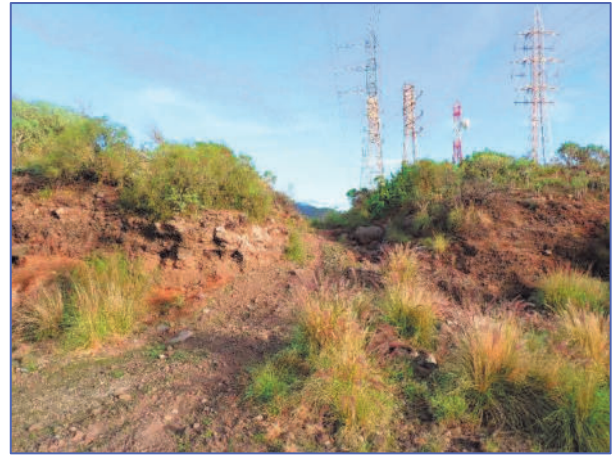
Fotografía 20: Aspecto de la vegetación en parte del trazado de la línea de evacuación. SET Polígono de Güímar al fondo.
