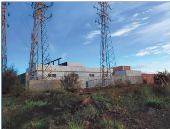
Fotografía 23: Aspecto de la vegetación en la SET Polígono de Güímar.
