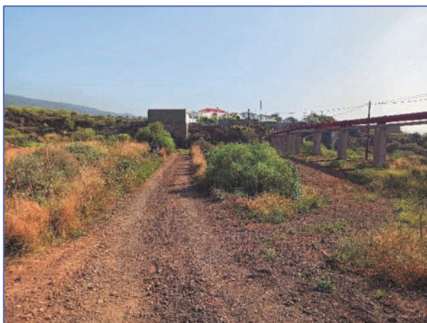
Fotografía 16: Aspecto de parte del trazado de la línea de evacuación.
