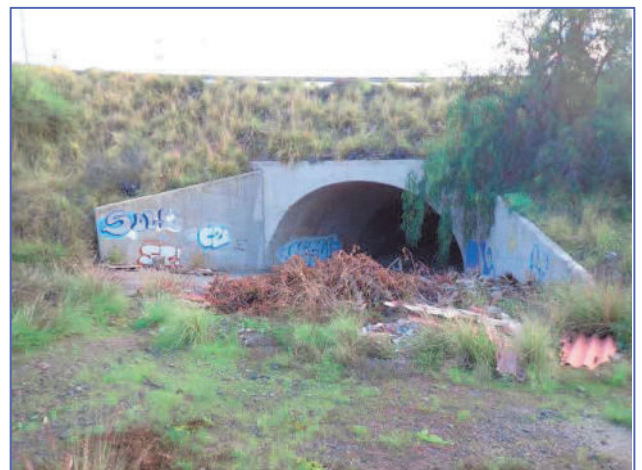
Fotografía 8: Cauce Las Balieras. Aspecto del tramo en la zona de cruce con la LMTS.
